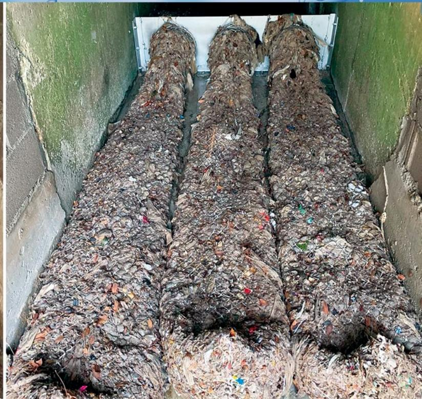
*Diseñados para retener elementos sólidos en los aliviaderos del alcantarillado*
